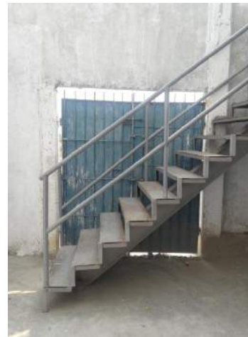
Escaleras de acceso a ambientes mal diseñadas e interrumpiendo vías de evacuación
