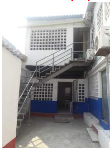
Escaleras de acceso a ambientes mal diseñadas e interrumpiendo vías de evacuación
