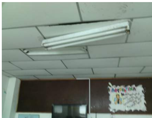
Luminarias en riesgo de caer y ocasionar accidentes
