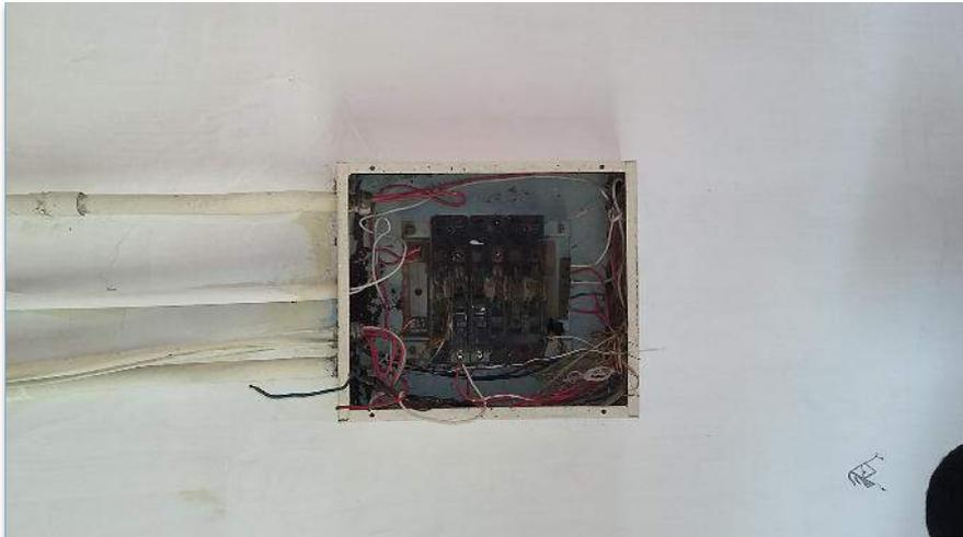
Cables eléctricos expuestos al contacto de los aprendices, además sin tapa de protección.
