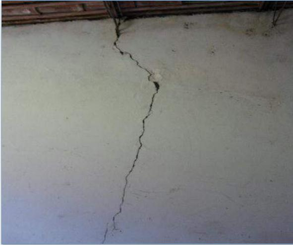
Paredes agrietadas, con posibilidad al colapso.
