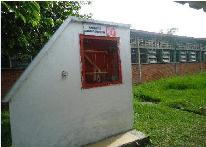
Gabinetes se sistema contraincendio sin los elementos y sin mangueras. Completamente vacías.
