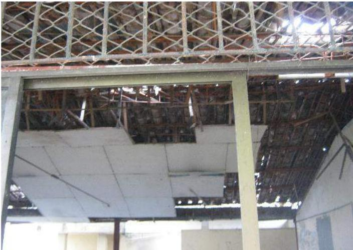
Cielo falso y techo con goteras y deteriorado.
