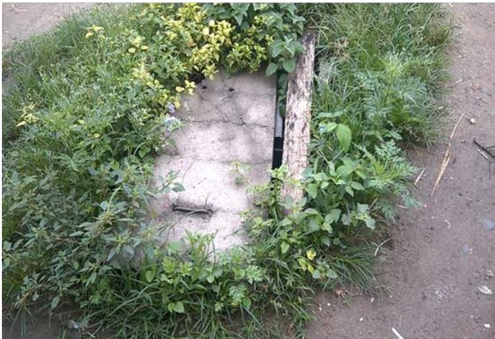
Tapas de cajas de desagües en mal estado.
