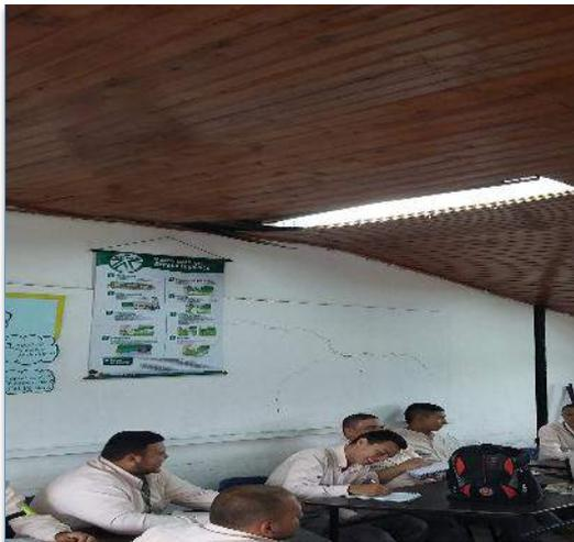
Paredes agrietadas y cielo falso en mal estado en aulas de clases.
