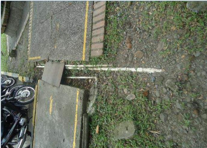
Riesgo de caídas: Andenes fracturados e incompletos, tubería expuesta a rupturas.
