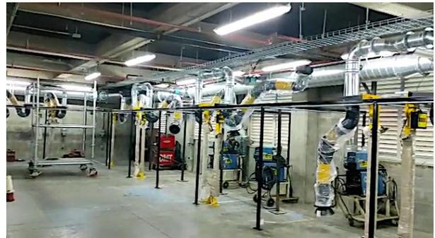
Otra irregularidad muy preocupante que se puede observar es el conducto de extracción de aire con tubería galvanizada el cual a simple vista presenta rastros de oxido en todo su recorrido en el exterior, lo cual es inconcebible si tenemos en cuenta que un tubo galvanizado precisamente se usa para evitar que lo afecte rápidamente la corrosión cuando es expuesto al medio ambiente y esta tubería a las pocas semanas de puesta ya muestra rastros de corrosión.
